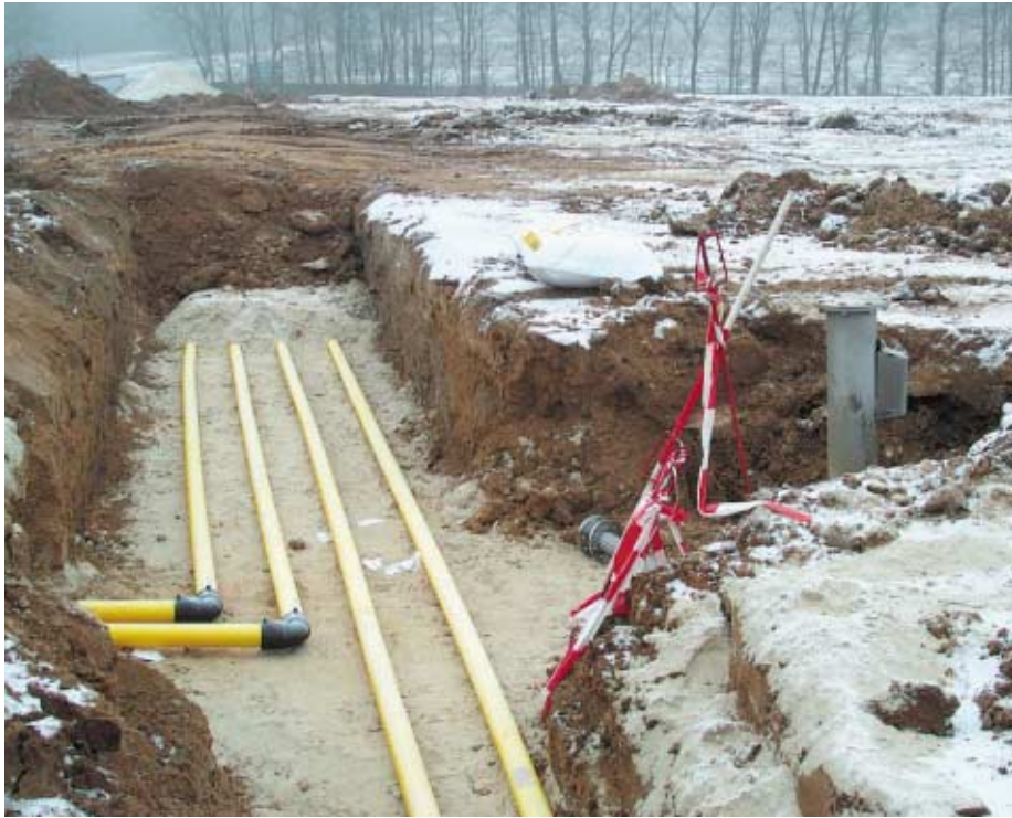
Verlegung der Gassammelleitungen
