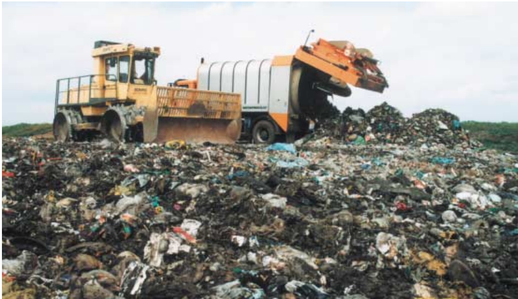
Deponie Pritzwalk im Betriebszustand
