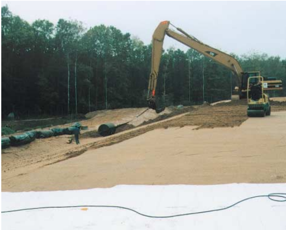
Einbau Trisoplast im Randbereich
