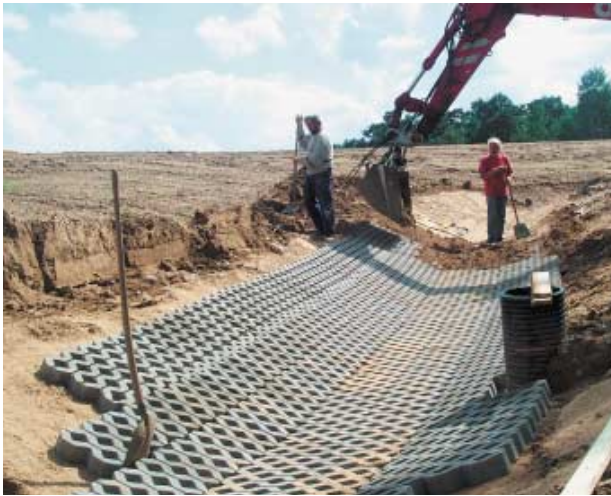
Auslegen des Randgrabens mit Rasengittersteinen
