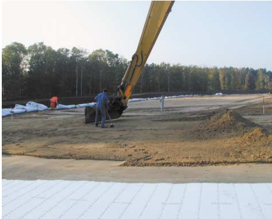
Trisoplasteinbau – Verteilung mit Langarmbagger
