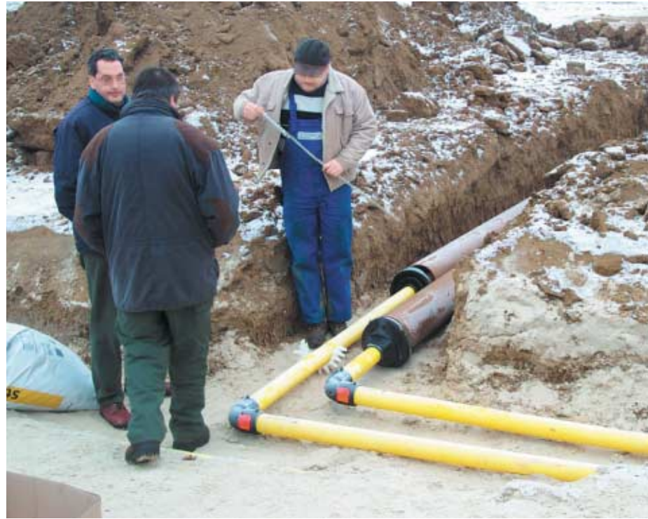
Verlegung der Gassammelleitungen
