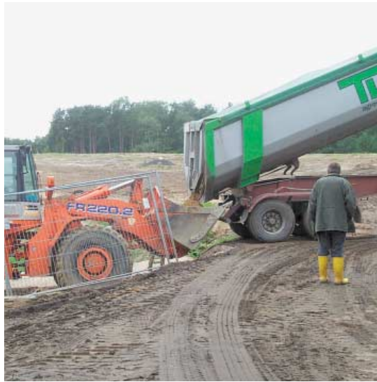
Anlieferung Trisoplast auf der Deponie
