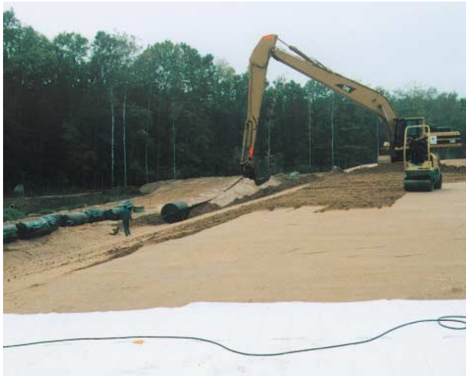
Einbau Trisoplast im Randbereich
