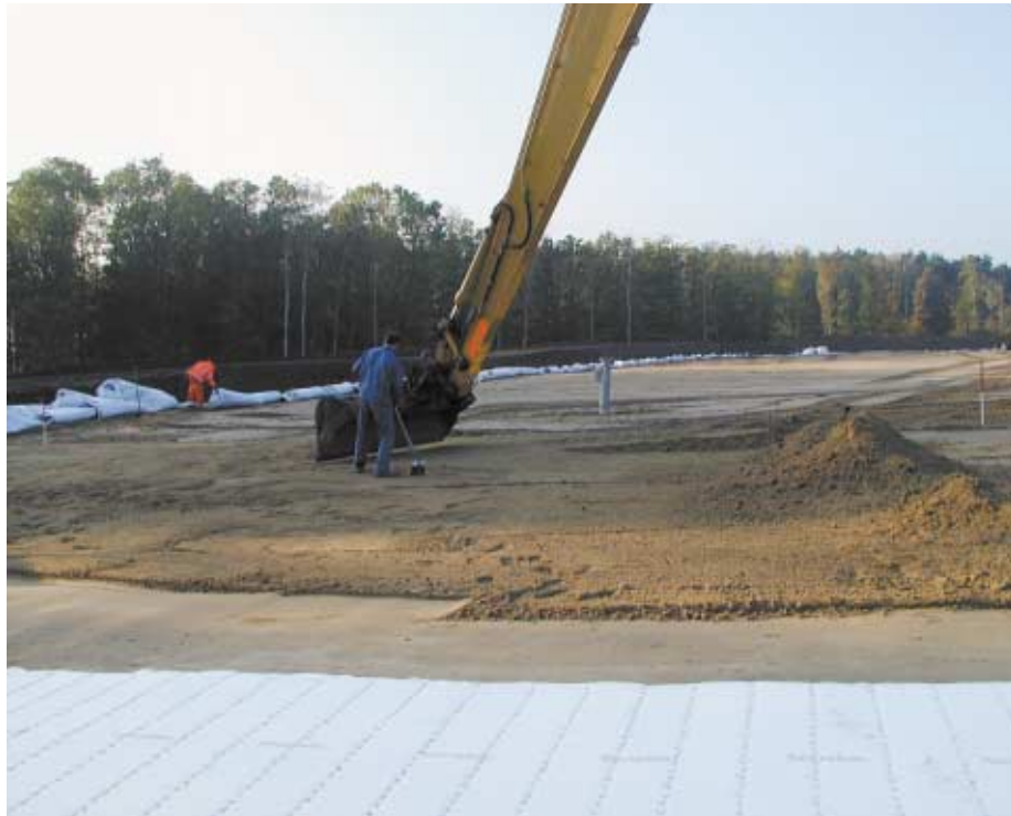
Trisoplasteinbau – Verteilung mit Langarmbagger
