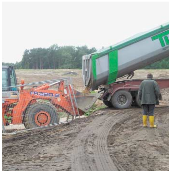
Anlieferung Trisoplast auf der Deponie
