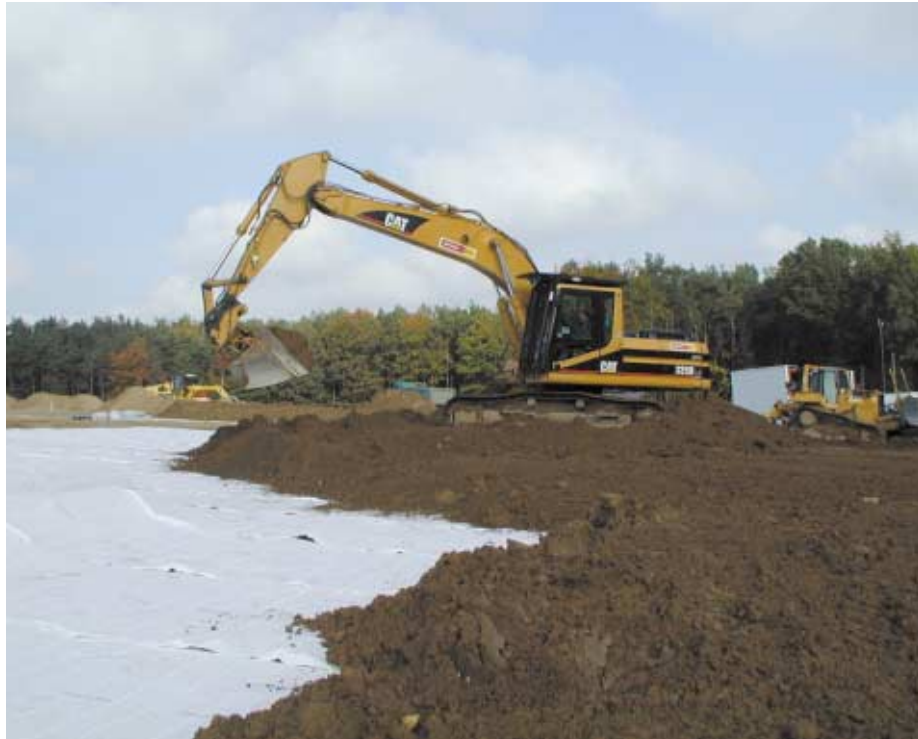
Einbau des Rekultivierungsbodens
