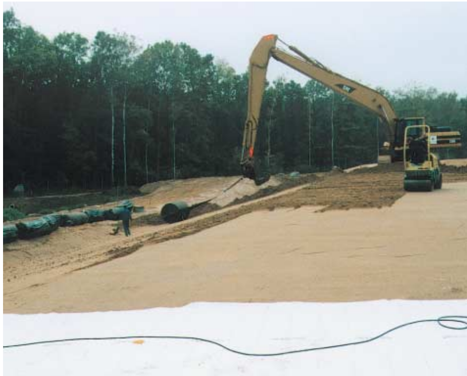
Einbau Trisoplast im Randbereich
