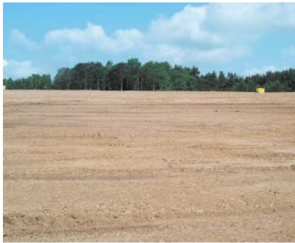
fertige Oberflächenprofilierung vor Anspritzbegrünung
